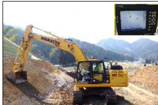
ICT建設機械による施工
