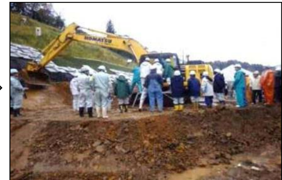
地元建設業者への見学会
