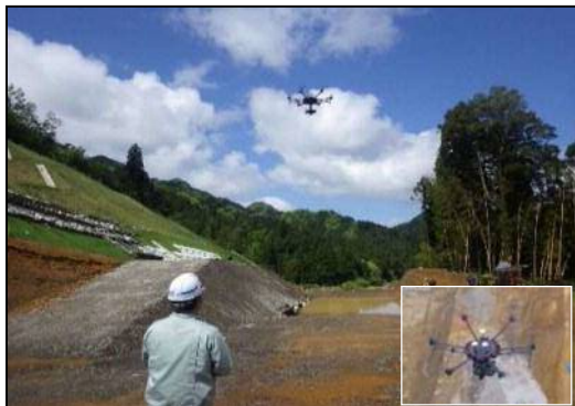
ドローンによる写真測量
